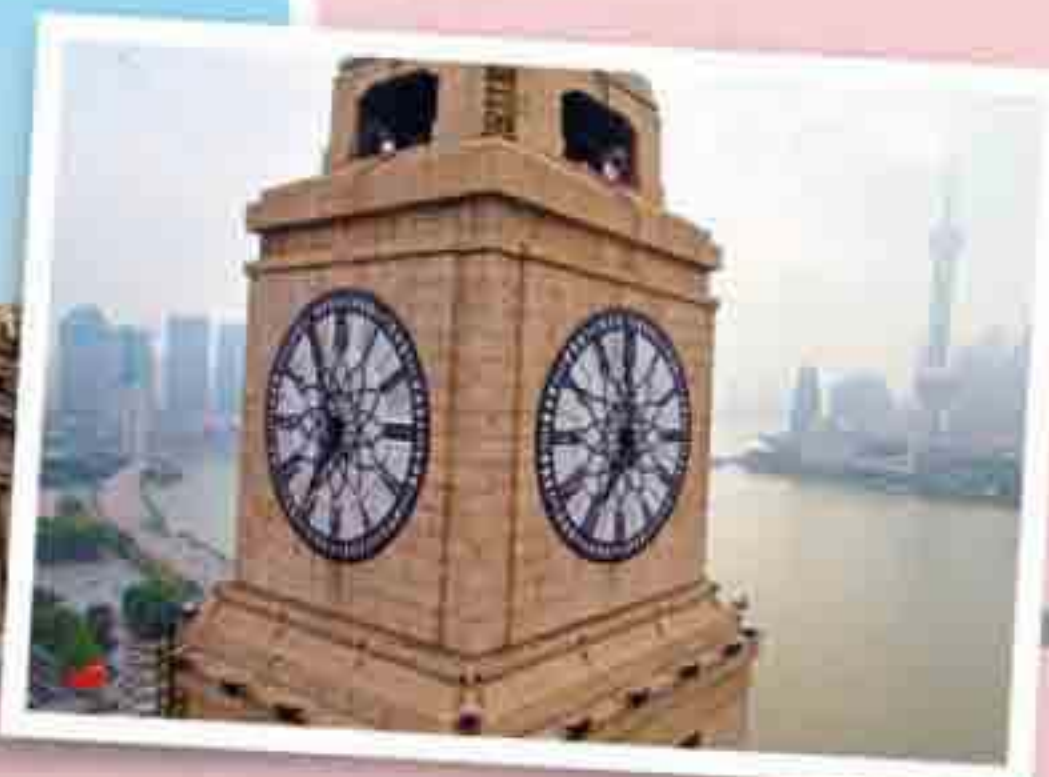
海關大樓，外灘建築群的最高樓。鐘樓的四面鐘與倫敦大笨鐘的款式相同，在英國製造，再運到上海組裝。
