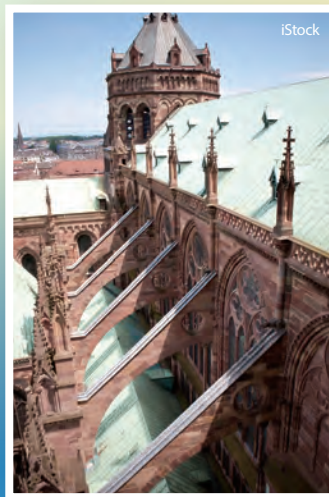
支撐教堂的飛扶壁。
